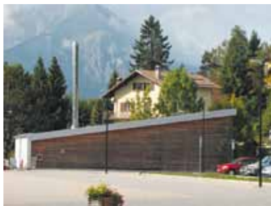
La centrale termica a biomassa
